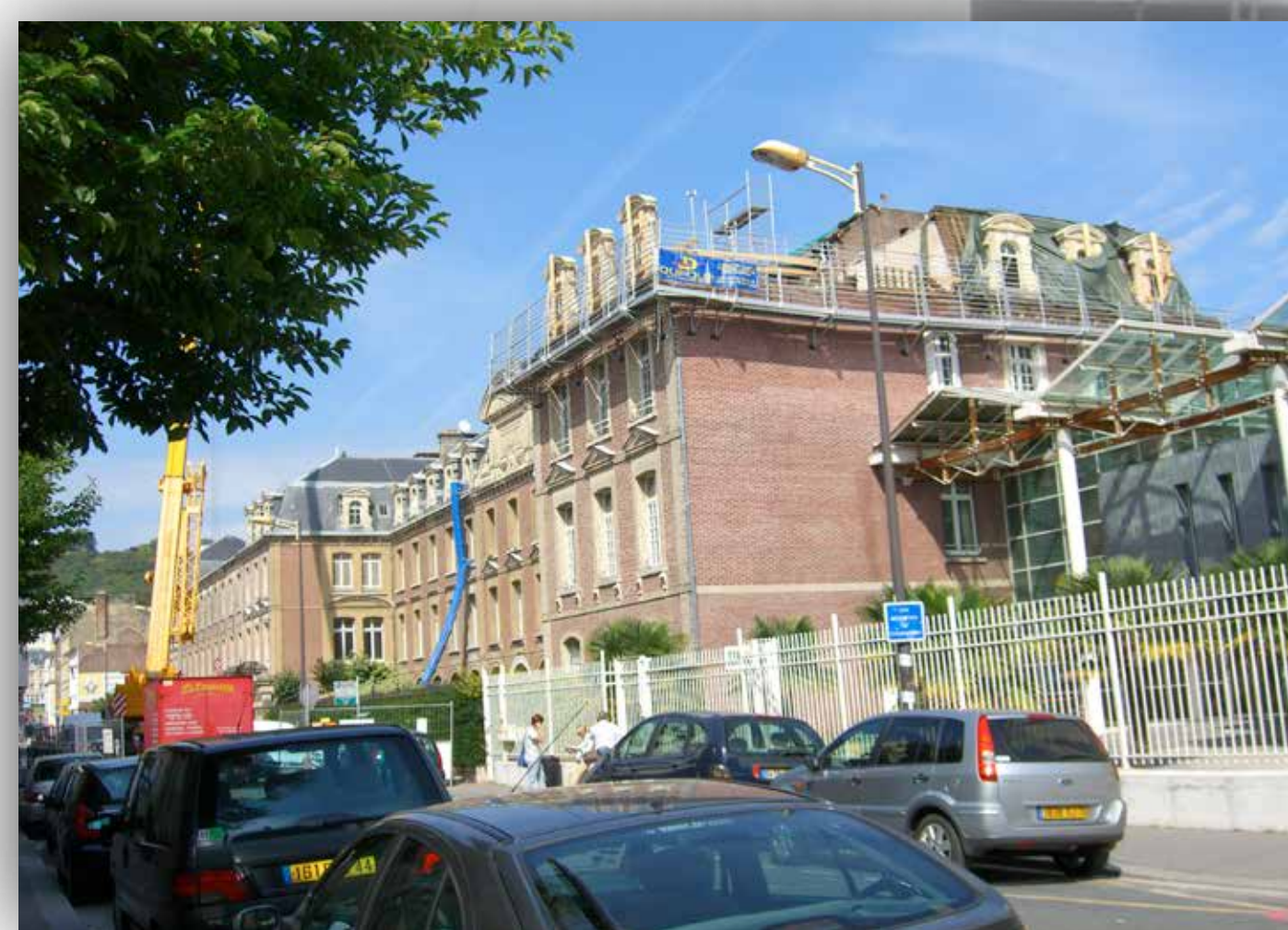
2011, nouveaux travaux de restauration et de rénovation de l'aile, côté rue Jean-Paul Sartre © collection Philippe Manneville
